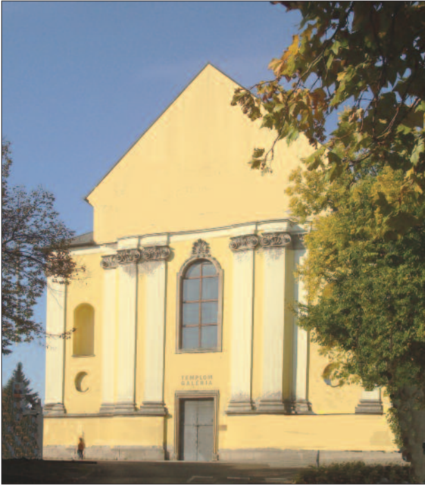
4. ábra. A trinitárius templom homlokzata
